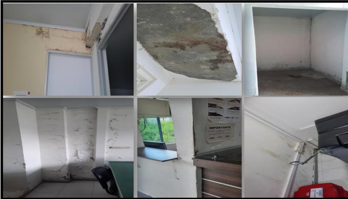
Imagen No.26. Centro de Salud Balcones
